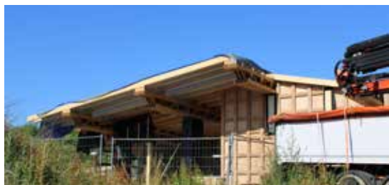
Après être sortie de terre, la Maison des Hommes et des Arbres a été rhabillée tout en bois...
