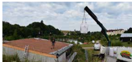
... et les travaux suivent leurs cours, avec la préparation du toit végétalisé.
