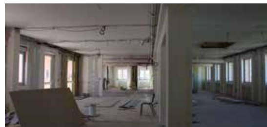
La future médiathèque prend forme progressivement.
