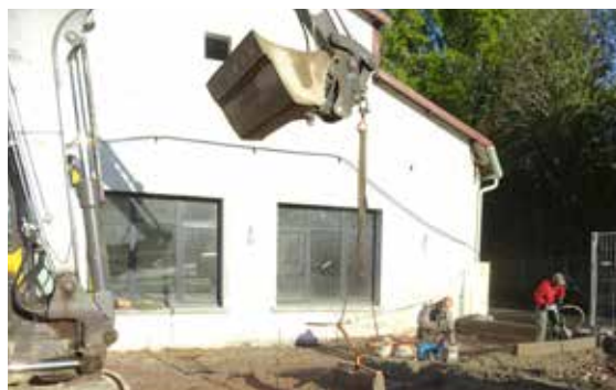
Les travaux sont en cours à l'intérieur comme à l'extérieur à la Maison des Associations !
