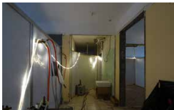
Opération de désamiantage en cours dans la future médiathèque.
