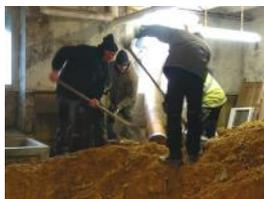
L'heure est venue de la **mise en accessibilité de la mairie**. Les travaux ont réellement débuté en ce début d'année avec le dégagement actuel de volumes au sous-sol afin de permettre l'installation d'un ascenseur. Ils se poursuivront avec l'installation d'une plateforme élévatrice à l'arrière du château et d'autres travaux de voirie, de mise aux normes. Travaux que vous pourrez suivre de près et en toute sécurité dans les prochaines gazettes.
