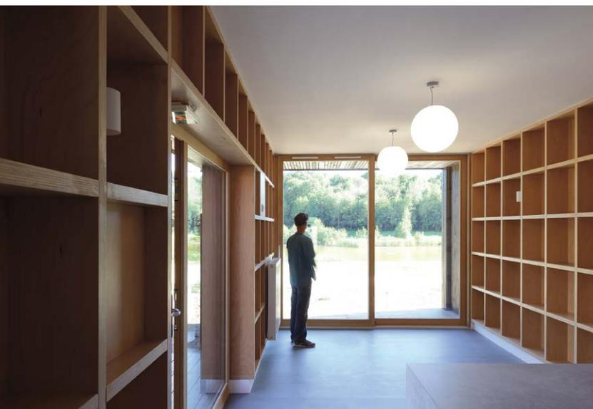
▲ Les murs du modèle Tetris sont constitués de caissons en hêtre remplissant à la fois le rôle structurel et d'agencement intérieur.
