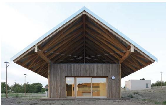
▲ Le Chalot : une imposante charpente en Douglas supporte une toiture à larges débords qui protège le bardage en hêtre thermotraité.
