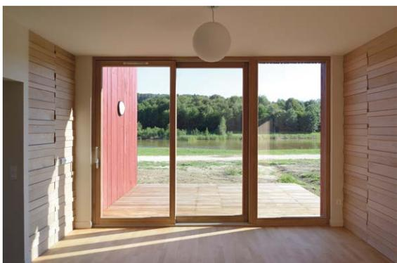
▲ Le contreventement intérieur en hêtre massif dans le gîte Kapla est réalisé avec des lattes courtes (assemblage à rainure et languette). À l'extérieur : le bardage en pin sylvestre et le platelage en hêtre thermotraité.
